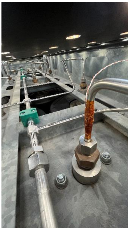
Abbildung 8: Nachgerüstete Messstellen 10-13 am Mitteldruckspeicher (Segmente 1-3)
