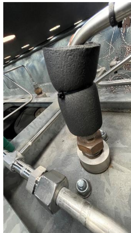
Abbildung 8: Nachgerüstete Messstellen 10-13 am Mitteldruckspeicher (Segmente 1-3)
