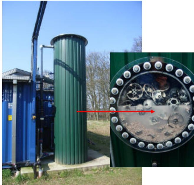
Abbildung 55: Tropfkörperkolonne mit Schaufenster (Füllkörper) zur biologischen Entschwefelung
