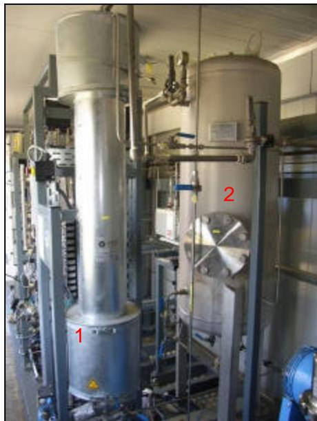
Abbildung 59: Kolonne zur Feinentschwefelung (1), Druckspeicher für feinentschwefeltes Biogas (2)
