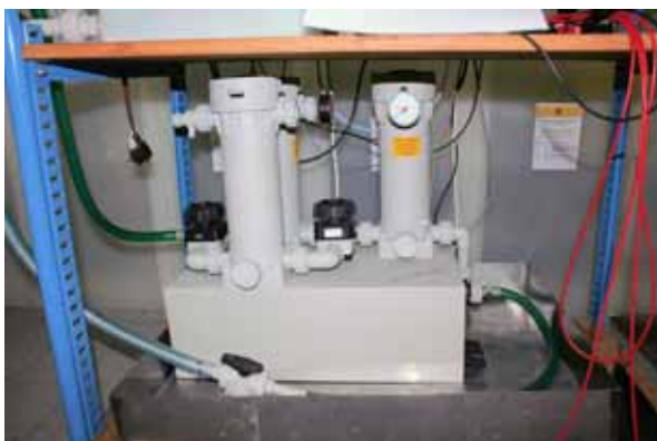
Abbildung 4.28: Pumpe mit drei Filtereinheiten (mit einem groben und einem feinen Filter und Aktivkohlefilter)
